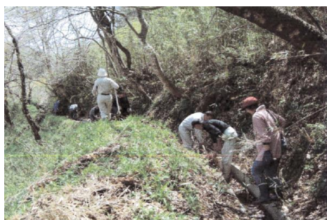
水路の泥上げ
