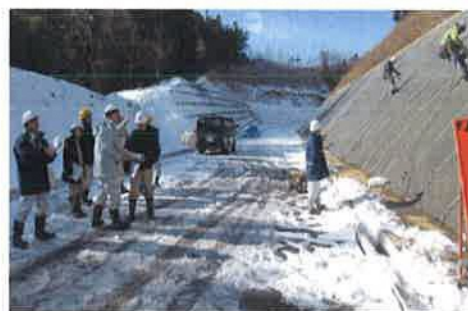
(アンカードリル施工中の状況)
